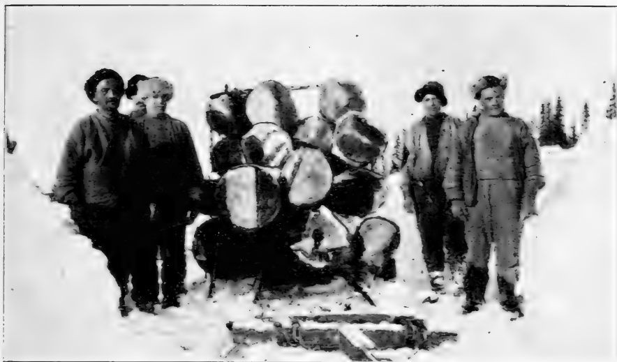
Fig. 6. Främre ändan av ett lass om cirka 600 kubf (=14 ton).
